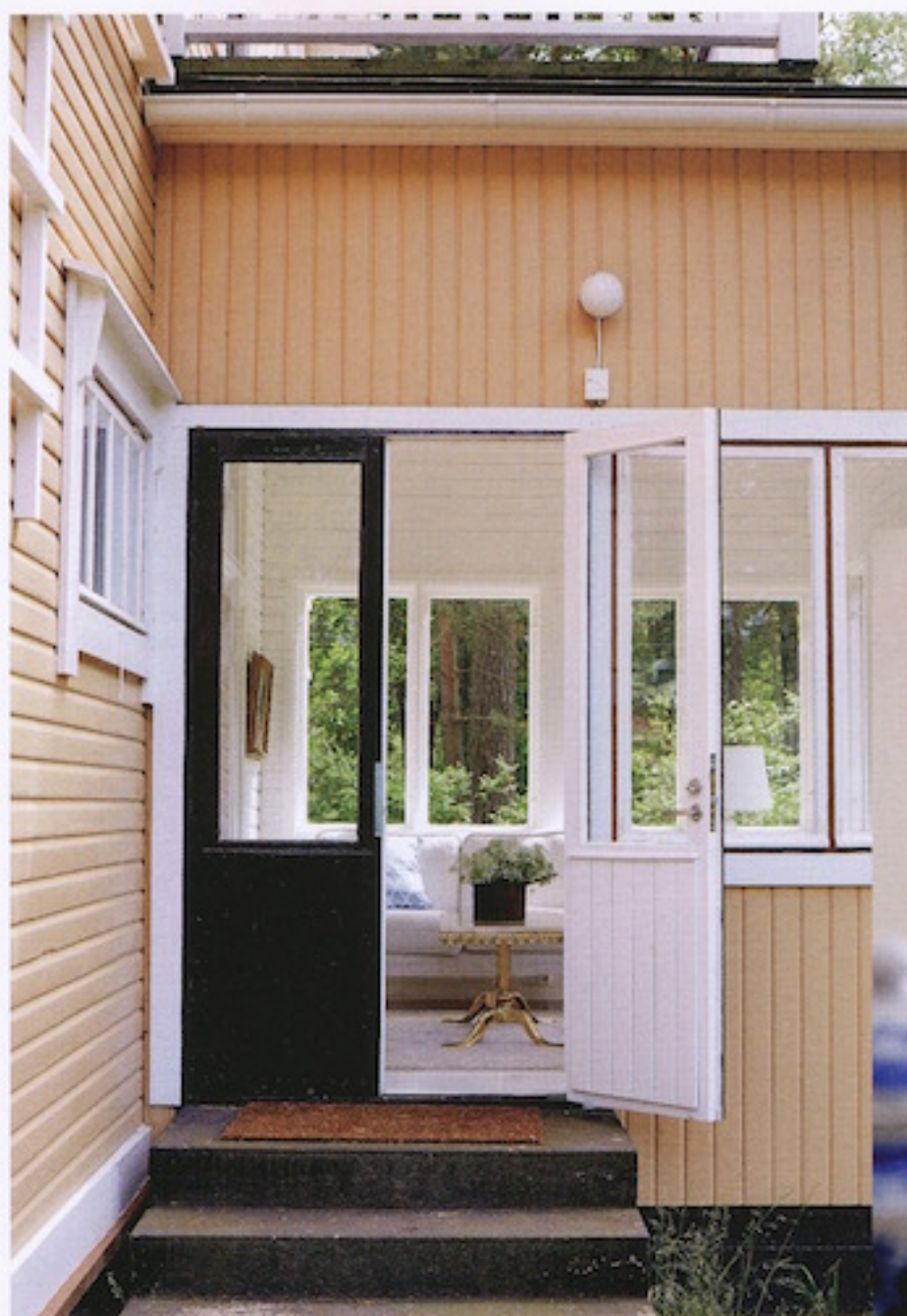
Velkommen ut. Flere steder i husets første etasje er det utgang til hagen.
